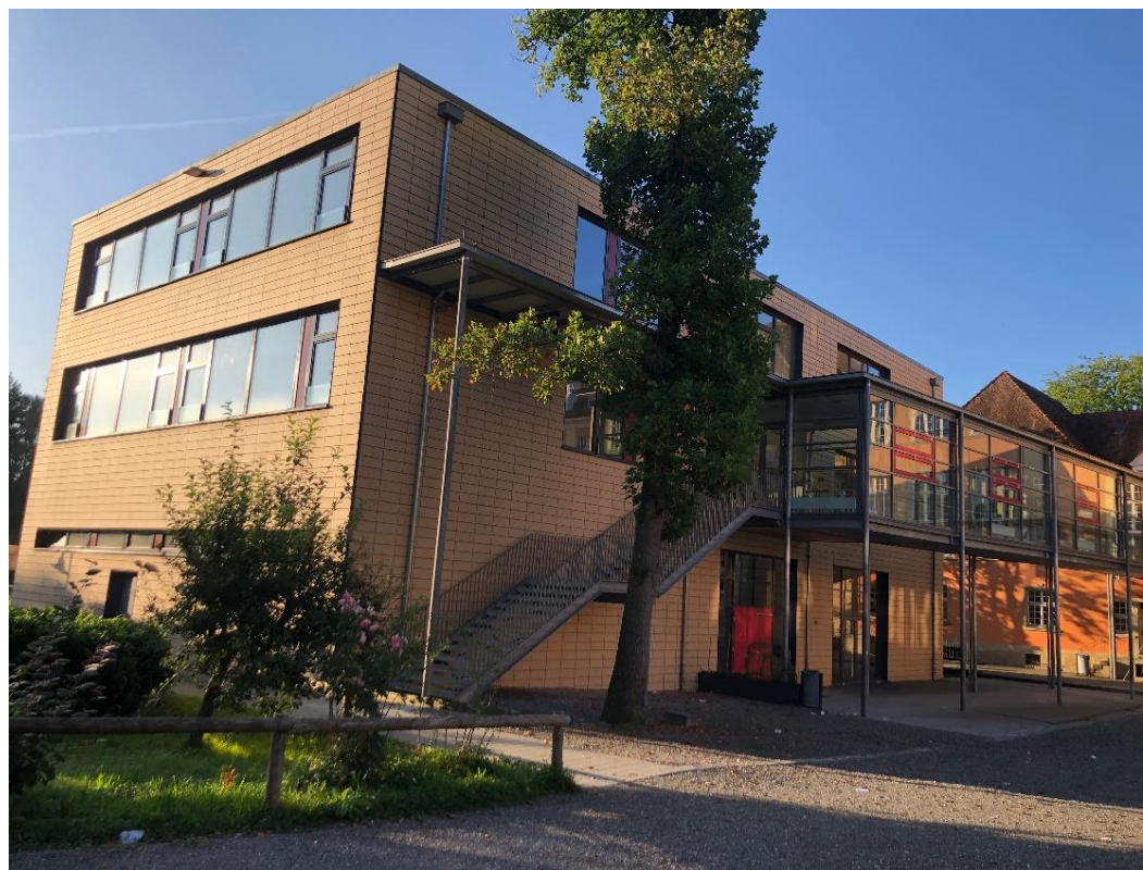
Neubau Suso-Gymnasium Neuhauser Str. 1 in 78464 Konstanz
