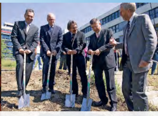
Spatenstich für den Neubau des Exzellenzclusters an der Universität Konstanz 2007.
